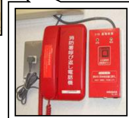
2F詰所の火災自動通報装置にて、消防・職員に通報
